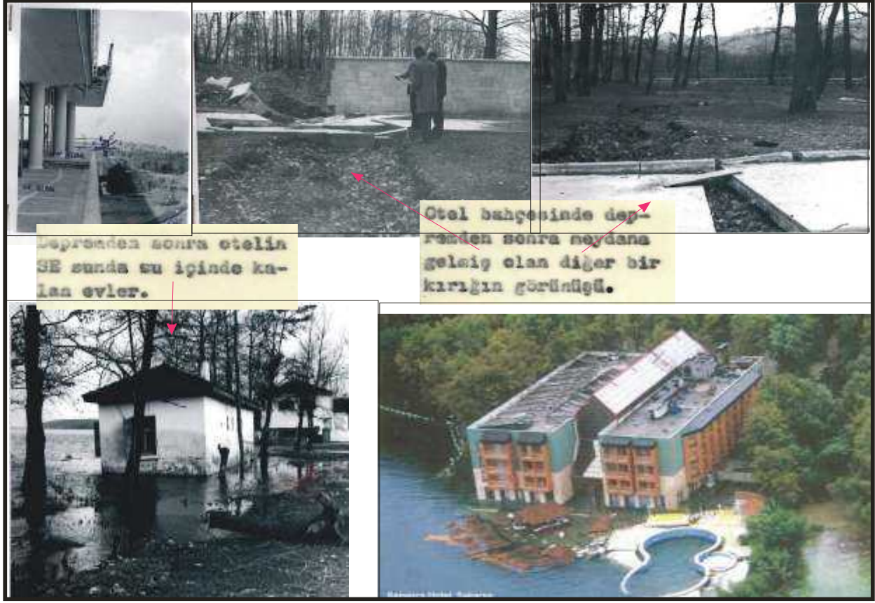
Şekil 1. Sapanca Vakıf Otel'i'nin ve civarındaki alanın, 22 Temmuz 1967 depreminden aldığı hasarlar ve zemin deformasyonları, 25.03.1968 tarihli Jeolojik Etüt raporunda AİGM mühendisi Jeolog Ziya Barut tarafından anlatılmaktadır. Sonuç kısmında ise, binada alınacak tedbir, tamir ya da güçlendirmenin, kısa ve uzun vadede tekrarlayan depremlerle bir fayda getirmeyeceğini belirtmektedir. Siyah – beyaz resimler 1967 depreminin yol açtığı bina ve zemin deformasyonlarını, renkli resimler ise 17 Ağustos 1999 depreminden sonra ağır hasara uğrayarak yan yatan ve Sapanca Gölüne kavuşan, daha sonrada yıkılan Vakıf Otelini göstermektedir.
